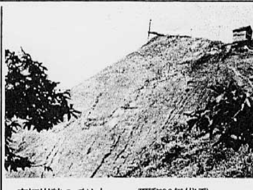
空知炭鉱のズリ山 (昭和10年代頃) 自然発火し、薄い煙が上がるズリ山もあった (写真提供：炭鉱博物館)
