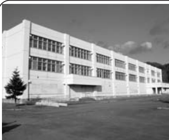
▲歌志内中学校の移転に向け工事が進められる旧歌志内高等学校
