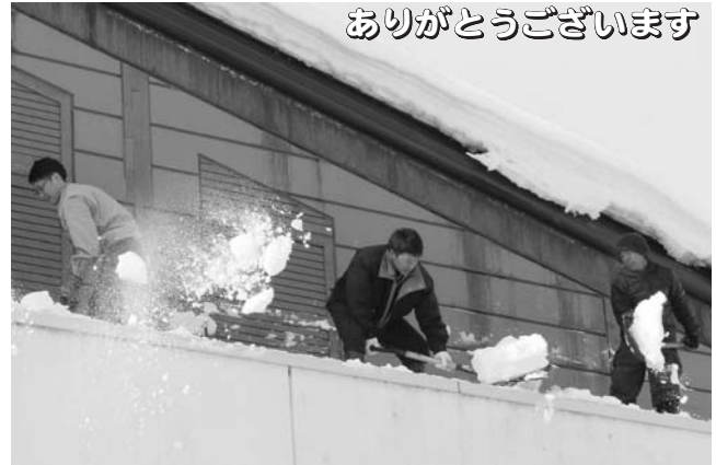
～建設協会除雪ボランティア～ ▲建設協会の皆さんにより、大雪により厚くつもった屋根の雪をきれいに落としていただきました。(3月5日 郷土館)
